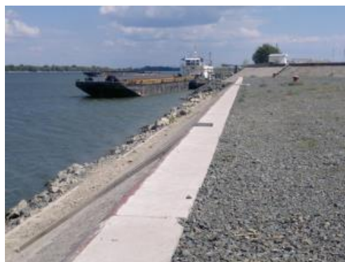
3 - Vedere spre incinta COMCEREAL
